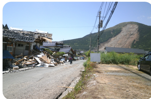
被害の大きかった阿蘇大橋周辺の地区
